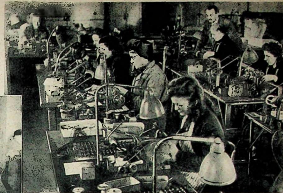
In der Spulenvickelei reiht sich Maschine an Maschine für alle möglichen Wicklungsarten. Links: Serienbau der verschiedenen Verstärker erfolgt in Bandarbeit
